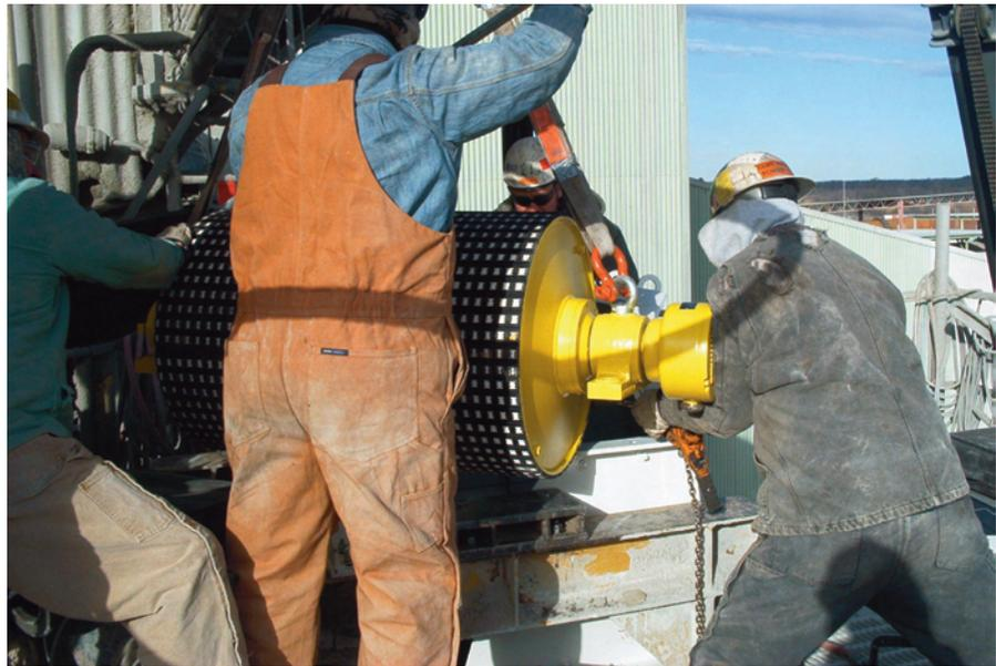
Figura 6. Dos Poleas Motorizadas de 1,850 lb (839.2 kg) se instalaron en un solo turno.
